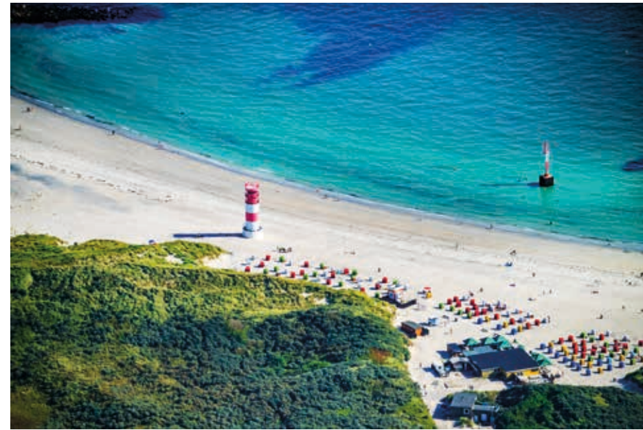
06 – Leuchtturm Helgoland Düne
